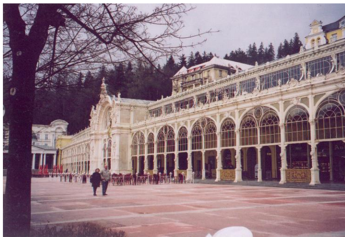
Figure 5: The spa hall of Mariánské Lázně. Photo: PFLÜGER 2007.
